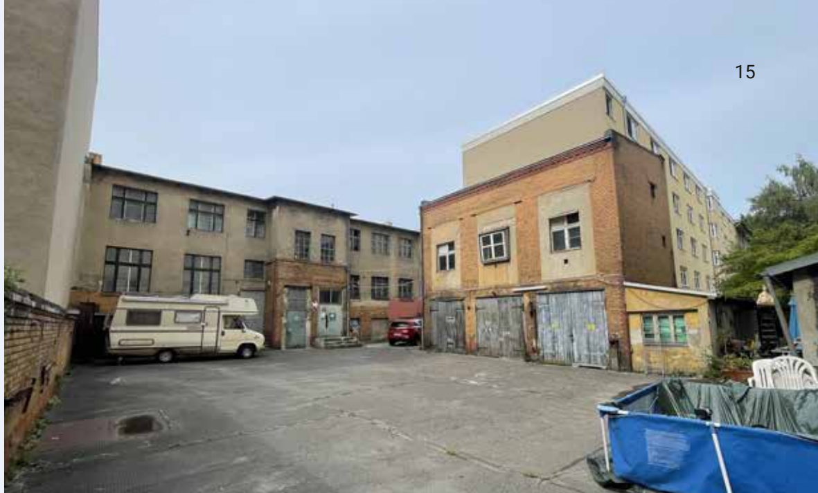
Innenhof vorher / Courtyard before
