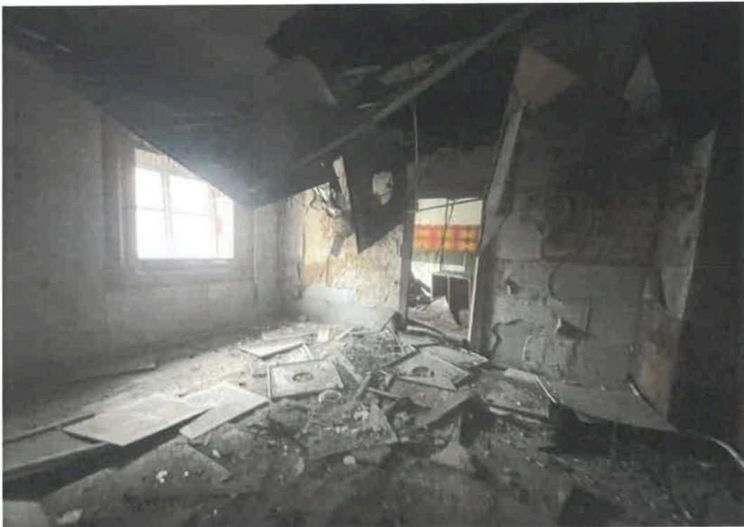
Abbildung 8: Innenansicht Werkstattgebäude im 1. Obergeschoß. Das Dach ist eingestürzt und der Boden löcherig.
