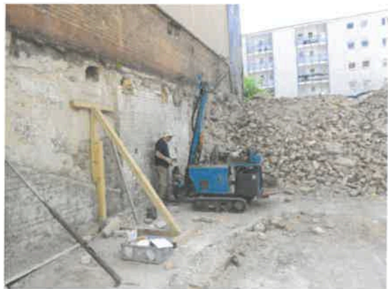
Abbildung 4: Ausbau GW-Pegel (GWM 3)
