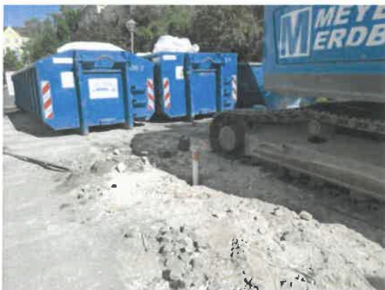
Abbildung 5: Ausgebauter GW-Pegel (GWM 1)
